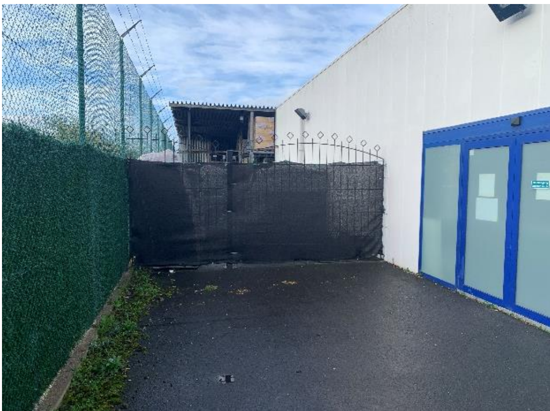
Foto 8: Zuidzijde tussen winkel en perceelsgrens
